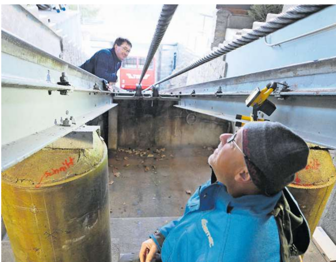
Das Zugseil der Treib-Seelisberg-Bahn wird einer regelmässigen Kontrolle unterzogen. Jetzt wird es erneuert. Bild: Christoph Näpflin (Seelisberg, 14. Januar 2020)
